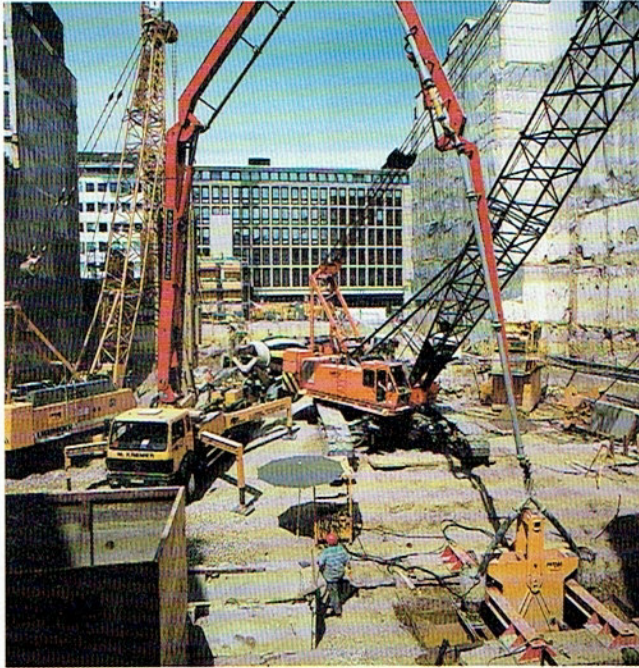
7 Betonieren eines Gründungskörpers einer Primärstütze
