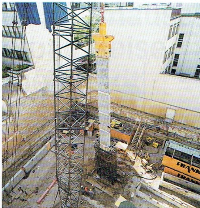
4 Einbau einer Primärstütze mit angehängtem Bewehrungskorb
